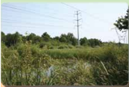
Double ligne 225 kV
